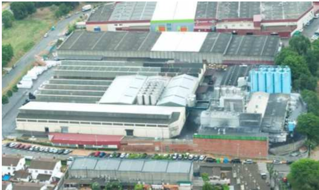
Palau I: servicios logísticos e ingeniería. Líneas de fillers, masterbatches blancos y negros de gran volumen.
